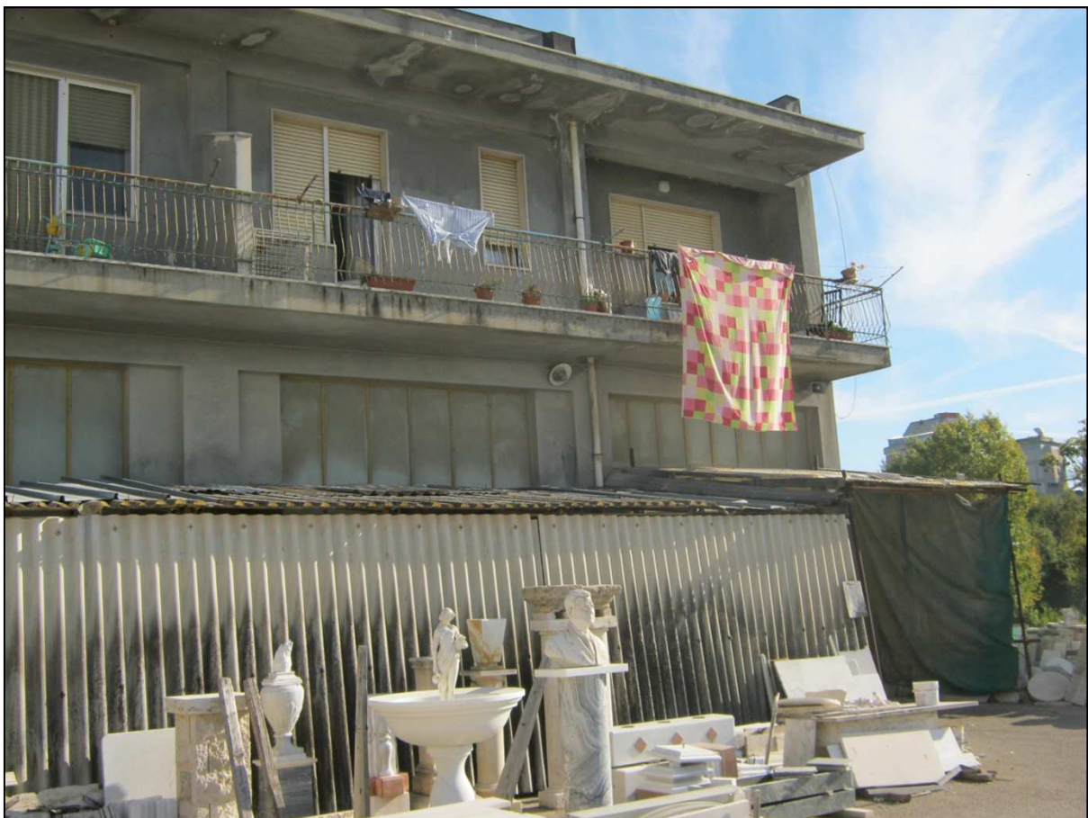
Foto n. 4: Abitazioni al piano primo.
